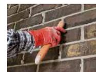
6.1. Acabado Clásico; Use una boquilla arenosa premezclada y prepare siguiendo las instrucciones del fabricante de la boquilla. Aplique en la junta usando una duya. Posteriormente, limpie los excesos con un cepillo plástico de cerdas suaves o esponja limpia. Finalmente, sugerimos ampliamente aplicar un sellador especialmente diseñado para productos de barro para proteger su fachada contra los efectos naturales de su exposición a la intemperie.
