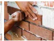
5.2. Coloque cemento adhesivo de contacto distribuyendo uniformemente sobre el muro usando una llana de ¼" x ¼" y presione el fachaladrillo sobre el adhesivo.
