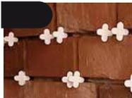
4. Marque líneas de apoyo horizontales con un tiralíneas sobre la superficie de instalación, para esto, realice un promedio de la altura de varias piezas de fachaladrillo para determinar la separación de las líneas, incluyendo el espesor de la boquilla, aproximadamente de 1 cm.
